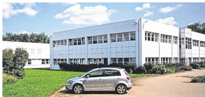
Seit 1991 ist im modernen Produktions- und Verwaltungskomplex der Otto Markert & Sohn GmbH an der Oderstraße die Fertigung textiler Filtermedien angesiedelt.
